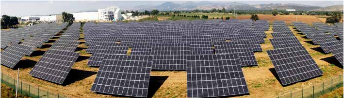
Parque Solar, México | Potencia de 3 MWp
